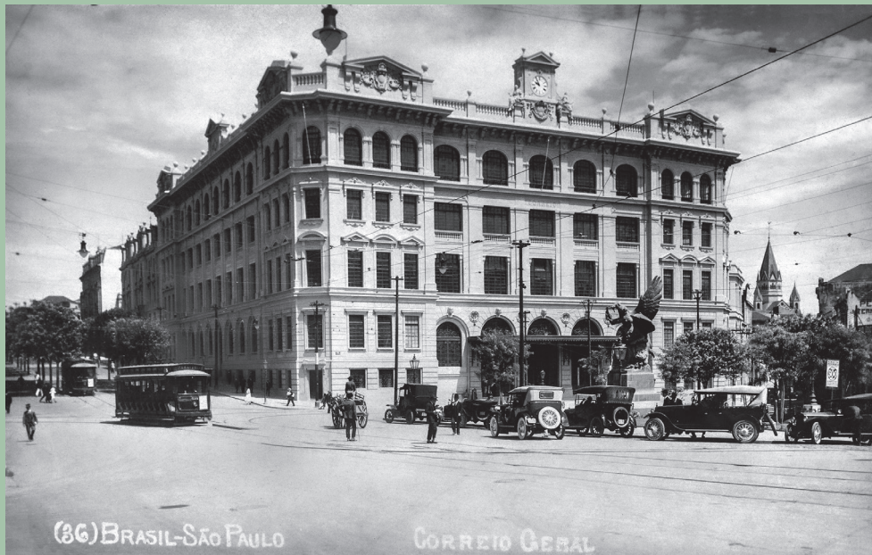
Fig. 7 - Também a um quarteirão de distância do Theatro Municipal, em 1922 o presidente Epitácio Pessoa veio a São Paulo inaugurar a nova sede da agência dos Correios e Telégrafos, como parte das iniciativas pela comemoração do Centenário da Independência. Projeto do Escritório Técnico Ramos de Azevedo, com a participação dos arquitetos Domiziano Rossi (1865-1920) e Felisberto Ranzini (1871-1976). Foto possivelmente da década de 1920
