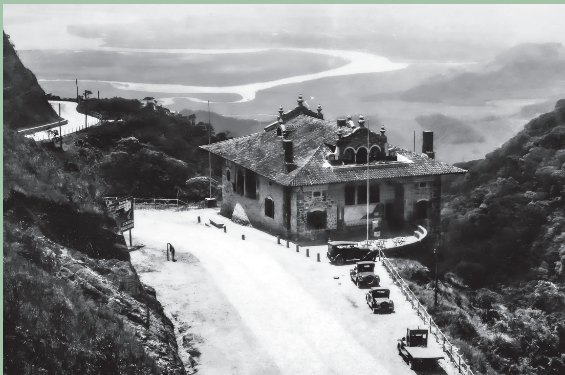
Fig. 6 - Pouso de Paranapiacaba (“Lugar onde se vê o mar”), um dos sete marcos criados por Washington Luís na Rodovia Caminho do Mar, 1922. Projeto de Victor Dubugras. Foto c. 1922
