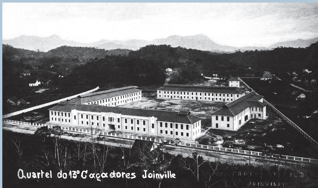
Fig. 10 - Quartel do 13º Batalhão de Caçadores, Joinville, Santa Catarina, 1921-1922. Os quartéis de Aquidauana e Joinville ostentam a mesma implantação geral, com pavilhões delimitando quadra interna e pela reprodução da arquitetura dos pavilhões. A repetibilidade da arquitetura era um recurso de racionalização dos processos construtivos. Foto de Alberto Diegel, da obra em acabamento
